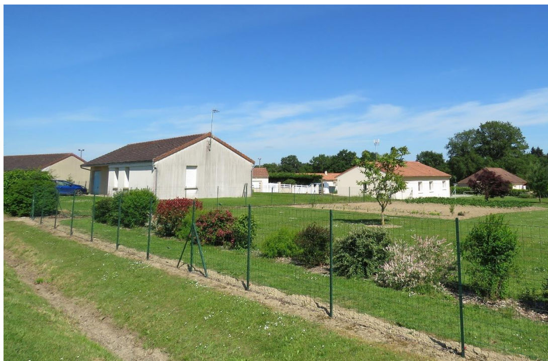
Construction récente au nord-ouest de Saint-Hilaire-la-Treille
