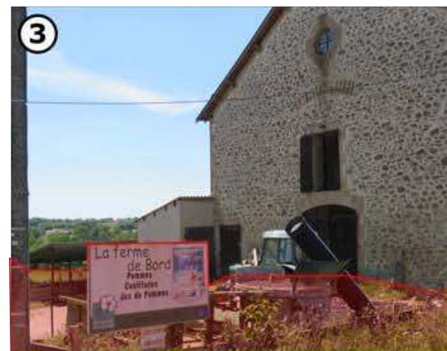
Vue sur la ferme de Bord en direction du sud-ouest au centre des terrains étudiés
